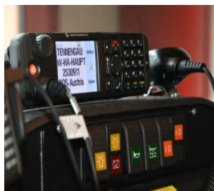
Einbau im Kommandofahrzeug
